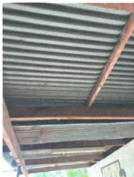
Foto 1: Sustitución de cubierta de techo con lámina galvanizada, Tipo de lamina: troquelada Calibre: 26, incluye: fijaciones y sellado en traslapes.
