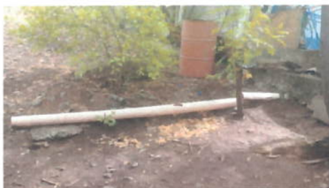
Foto 3: Sustitución de tubería PVC para redes hidráulicas de drenaje, adherencia entre cortes, uniones de tubería y accesorios con pegamento PVC
